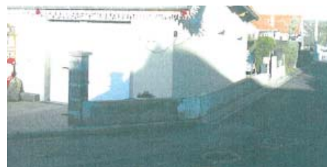
Illustration d'une clôture d'aspect non achevé : les parpaings utilisés restent apparents tout comme les joints ; l'application d'un enduit est dans ce cas impératif. Le muret peut être doublé d'une haie végétale ou d'une clôture ajourée.
