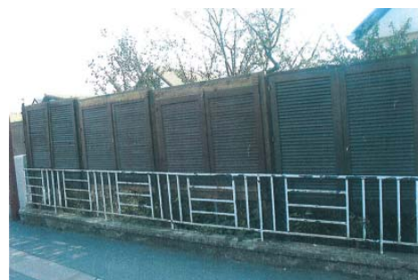
La clôture employée ici ne répond pas aux exigences du règlement du PLU : les fentes entre les lattes de bois sont trop faibles pour lui conférer un aspect ajouré, d'autant qu'elle mesure environ 2 mètres de haut.
