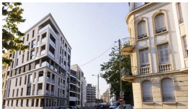
Réhabilitation de la friche Hospitalière Bon Secours
